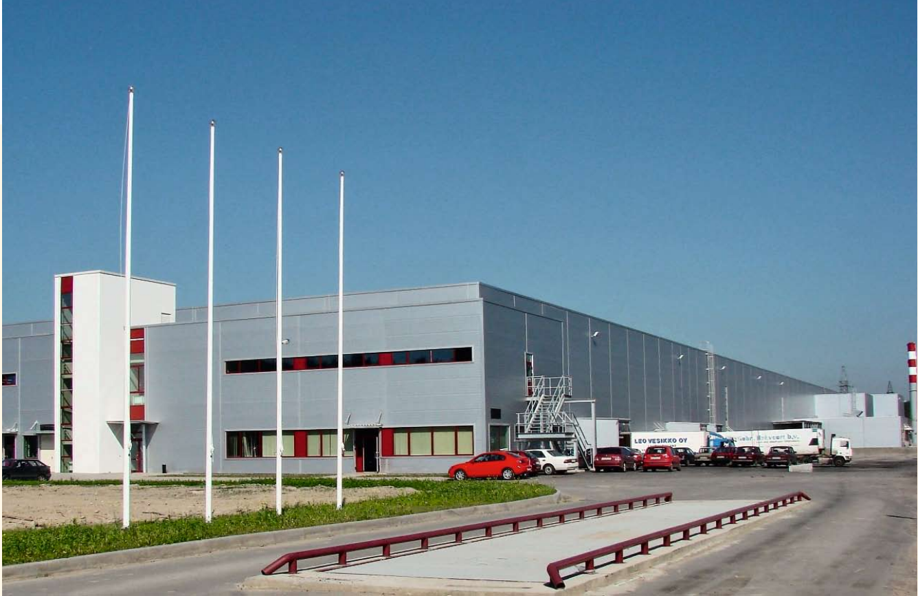
Die neue Kältegerätefabrik der BSH in St. Petersburg. Bilder: BSH
